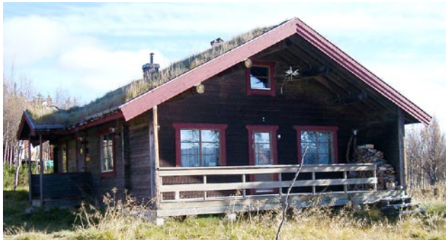
Altan placerad under gavelns takutsprång är acceptabelt på hus med smal gavel.
