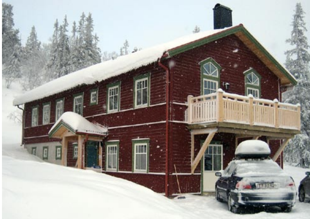
Sluttningshus med panel som följer marknivån
